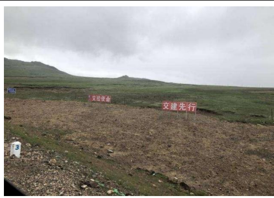
施工期土地整治
