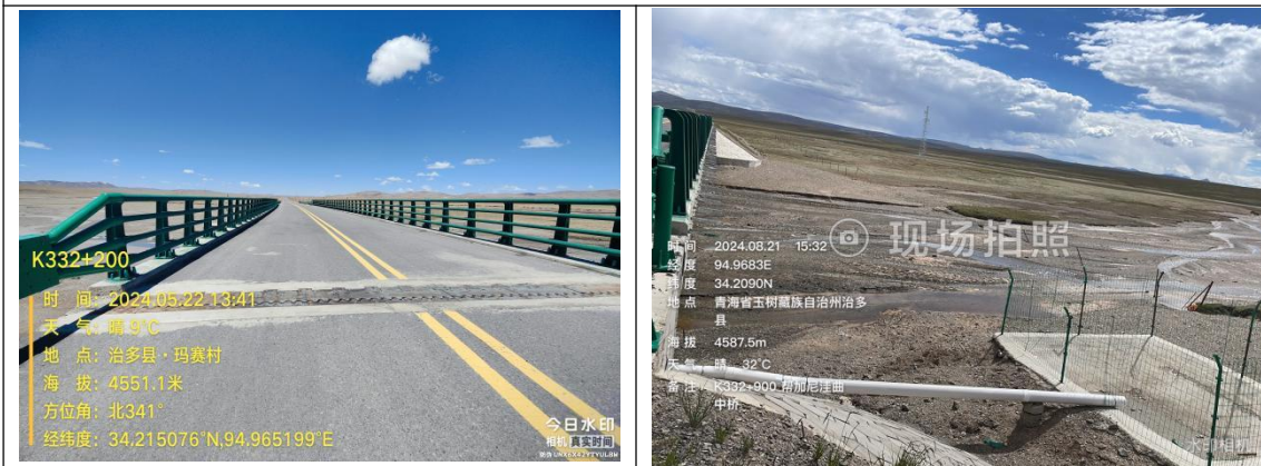
K332+252 邦巴塘曲卡中桥：桥面径流+收集池（18m 3 ）
