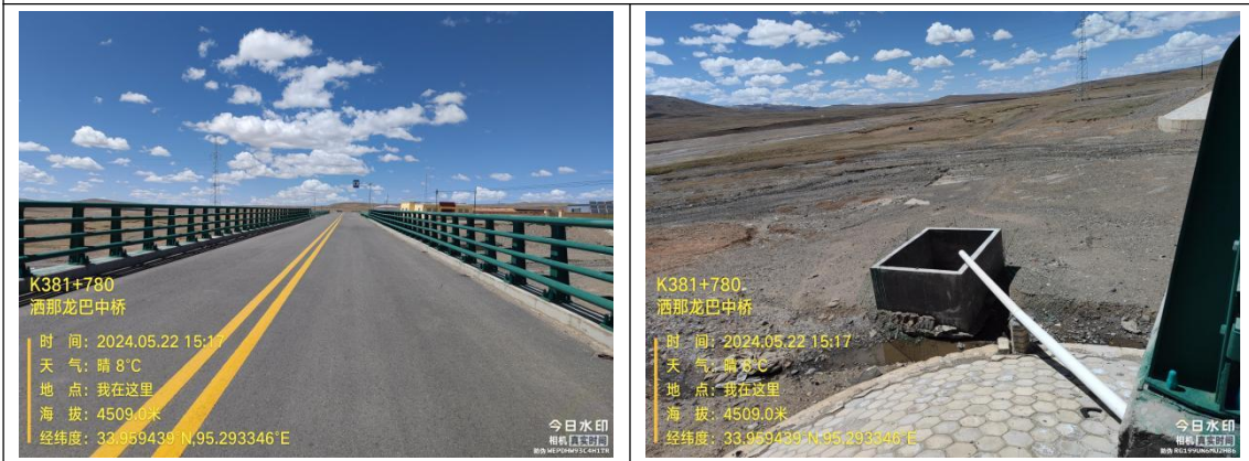
K381+780 洒那龙巴中桥：桥面径流+收集池（18m 3 ）
