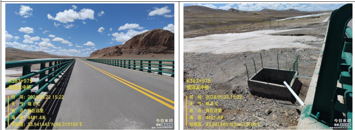
K383+975 俄错龙中桥：桥面径流+收集池（18m 3 ）
