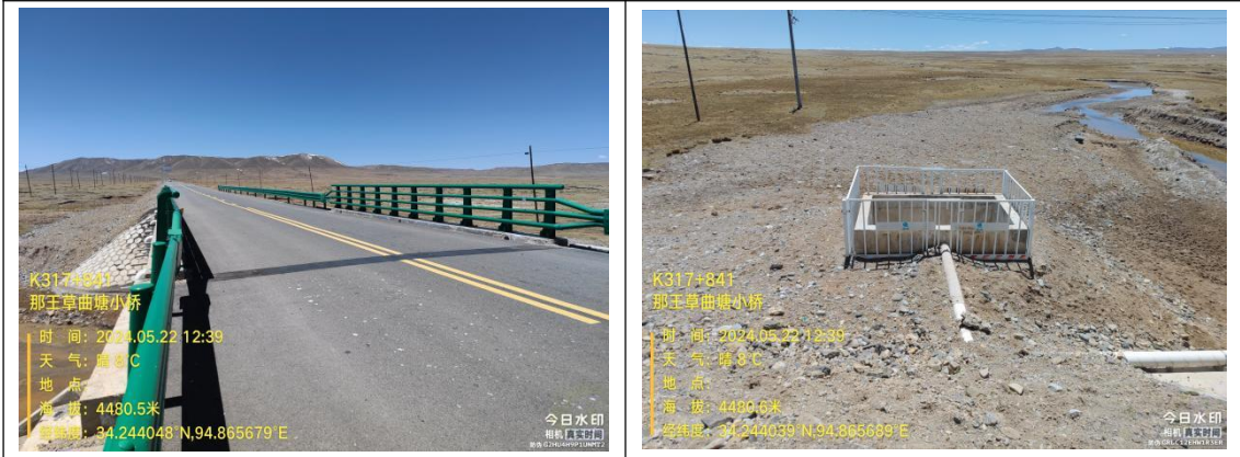
K317+842 那王草曲塘小桥：桥面径流+收集池（9m 3 ）
