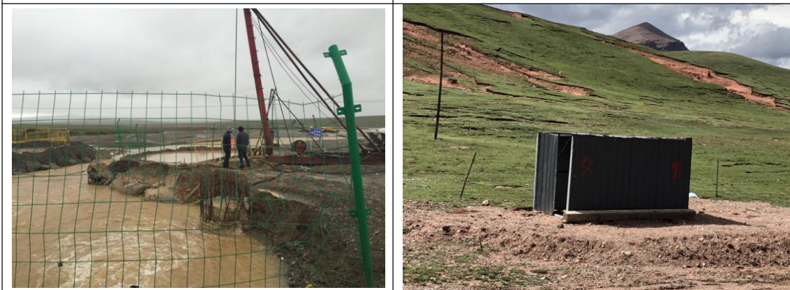
桥梁桩基施工设泥浆沉淀池
