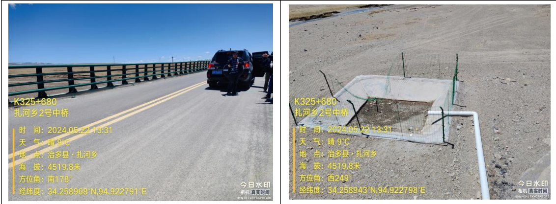
K325+720 扎河乡 2 号中桥：桥面径流+收集池（18m 3 ）
