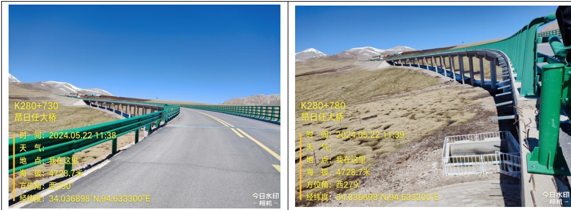
K280+730 昂日任大桥: 桥面径流+收集池 (18m 3 )
