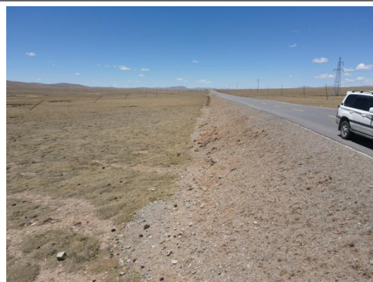
边坡撒播草籽
