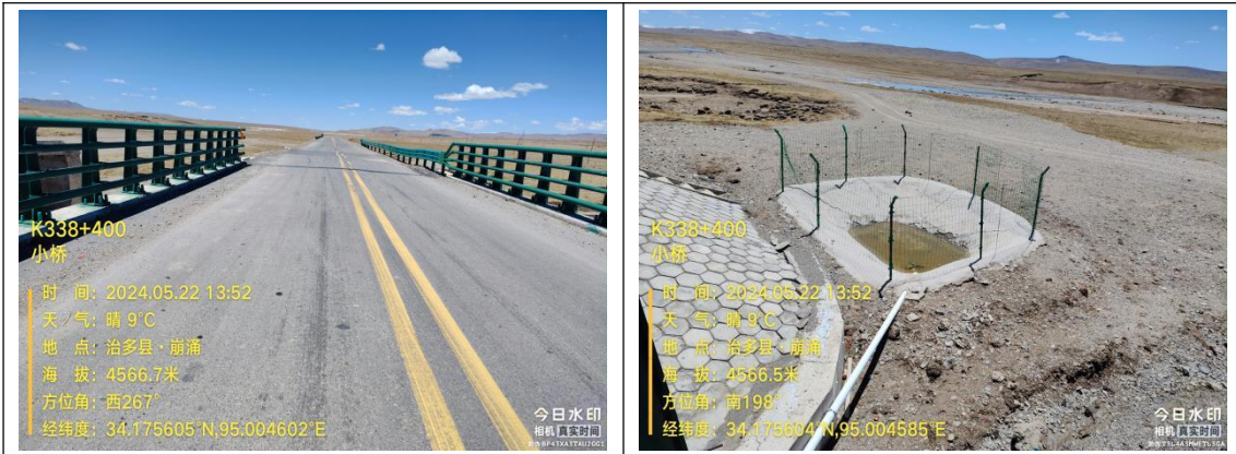
K338+400 小桥：桥面径流+收集池（9m 3 ）
