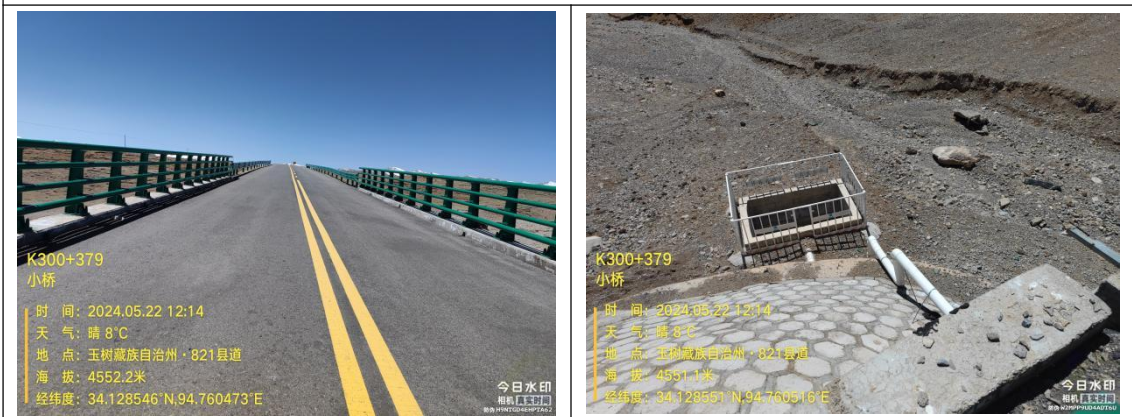
K300+379 小桥: 桥面径流+收集池 (9m 3 )
