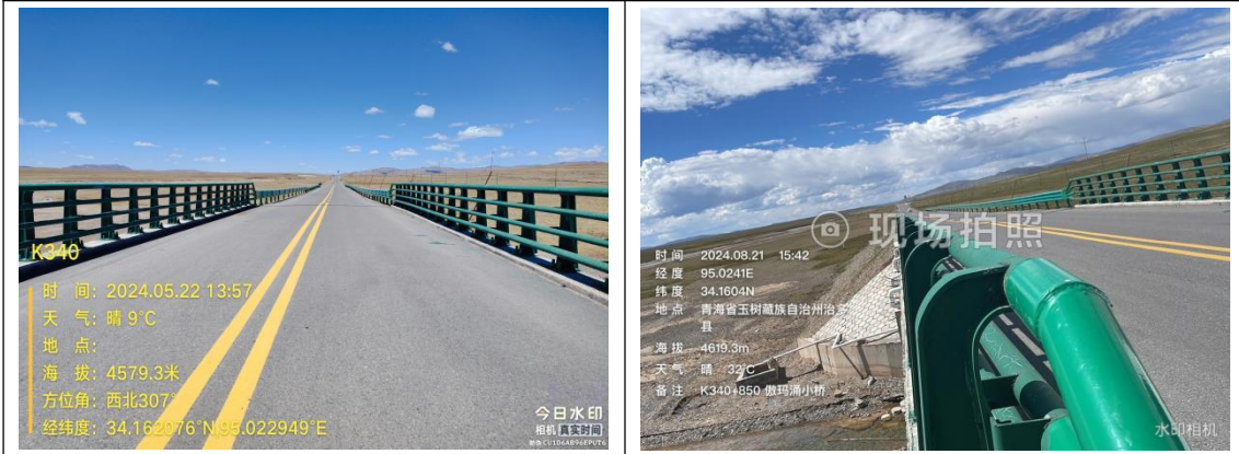
K340+600 傲玛涌小桥：桥面径流+收集池（9m 3 ）
