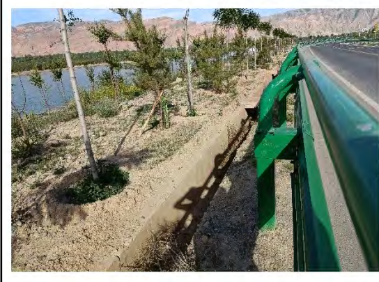
K1+230-K4+100 饮用水源保护区临河面加装高等级防撞护栏，在排水渠下设置应急池
