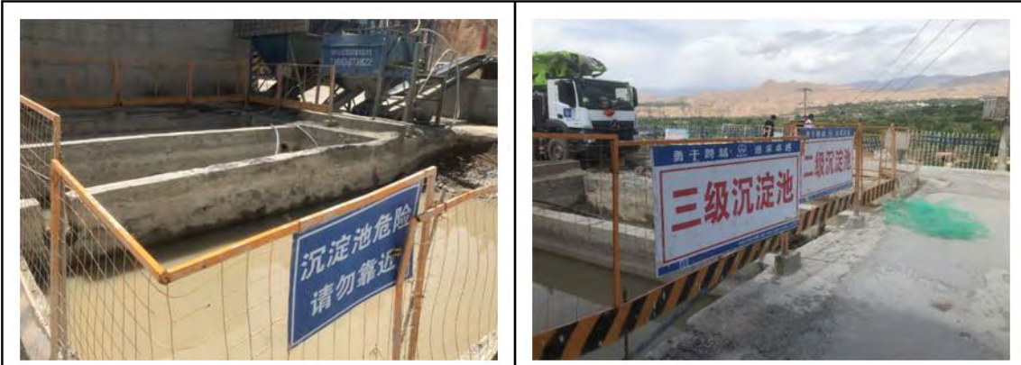
施工期水环境保护措施
