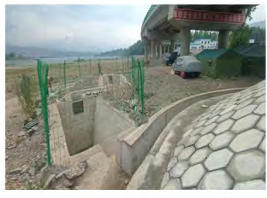
康家河滩大桥上部设置防撞护栏，安装桥面径流收集管道，桥梁下方修建防渗应急池
