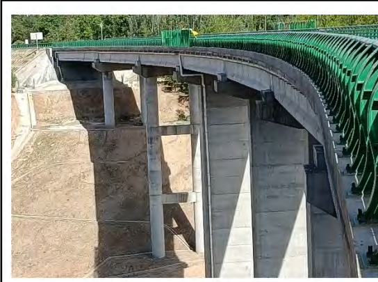
格曲大桥上部设置防撞护栏，安装桥面径流收集管道，桥梁下方修建防渗应急池
