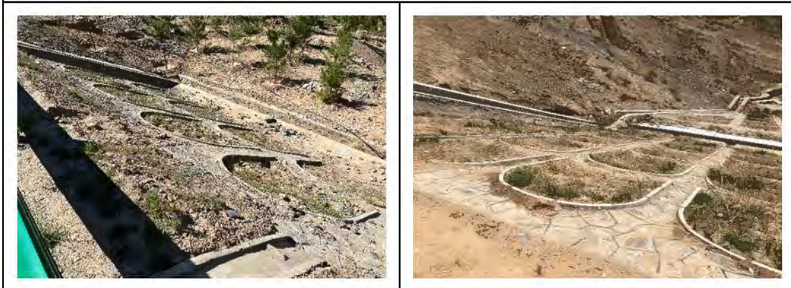
填方路基拱形护坡防护
