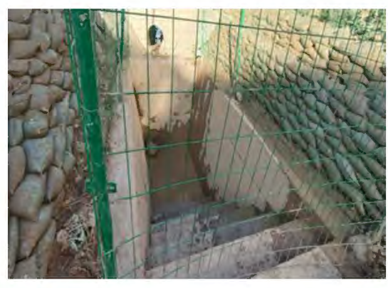
K1+230-K4+100 饮用水源保护区临河面加装高等级防撞护栏，在排水渠下设置应急池
