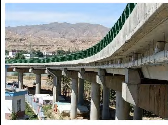
康家河滩大桥上部设置防撞护栏，安装桥面径流收集管道，桥梁下方修建防渗应急池
