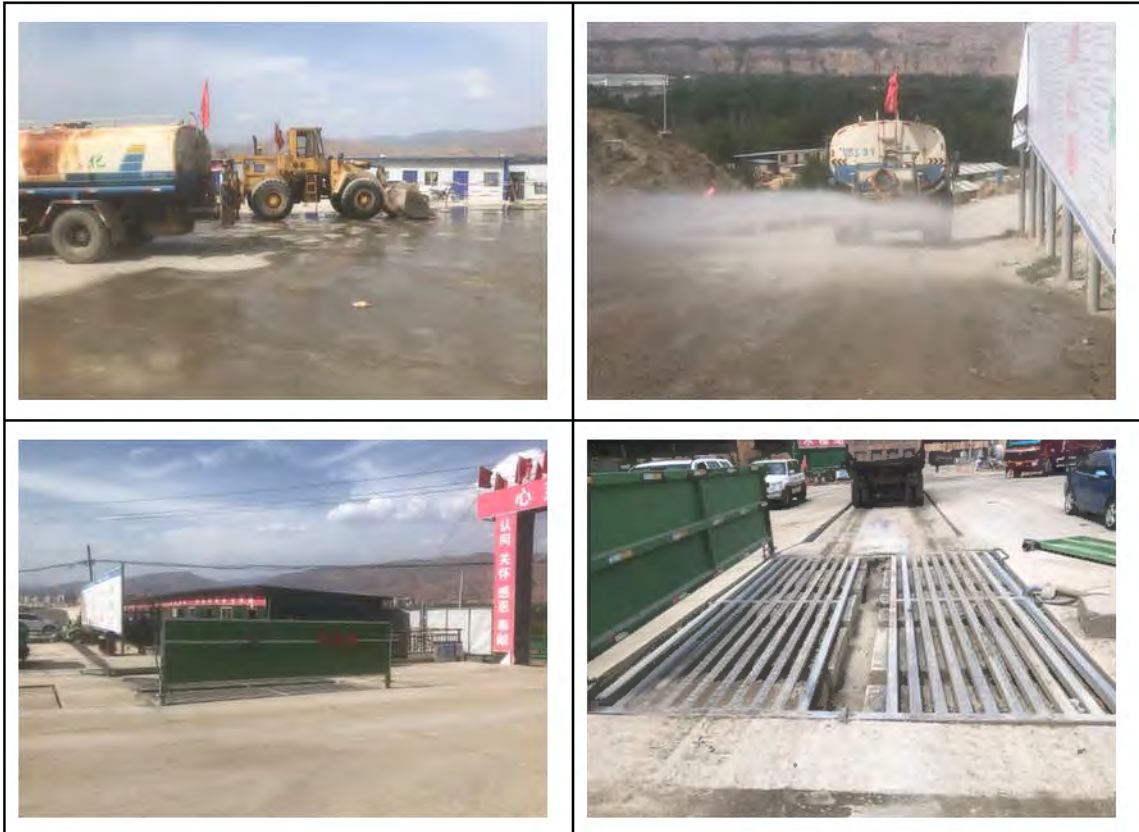
施工现场洒水降尘及车辆清洗装置
