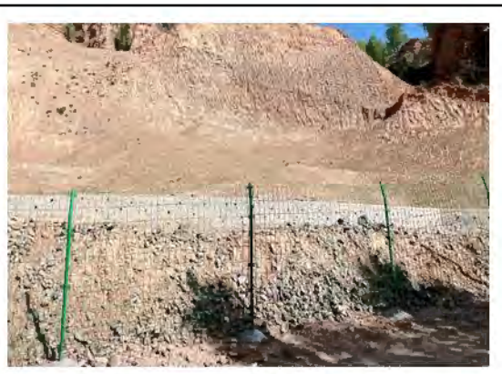
取土场修建排水沟、挡渣墙
