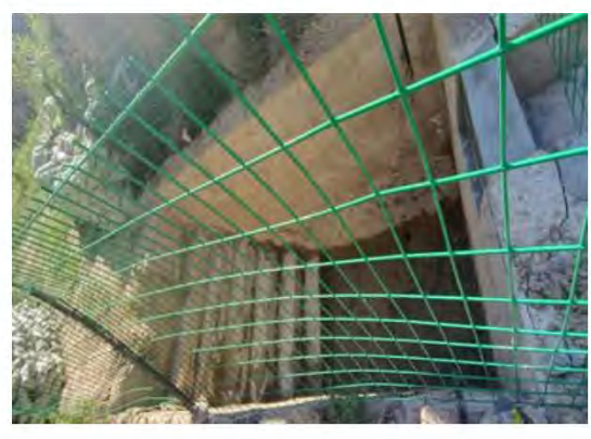
K1+230-K4+100 饮用水源保护区临河面加装高等级防撞护栏，在排水渠下设置应急池
