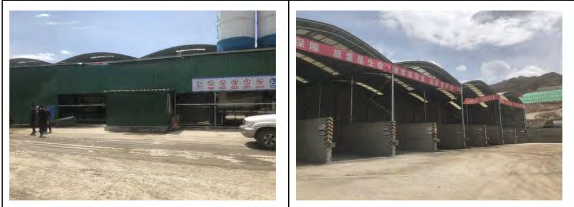
拌合站防尘设施
