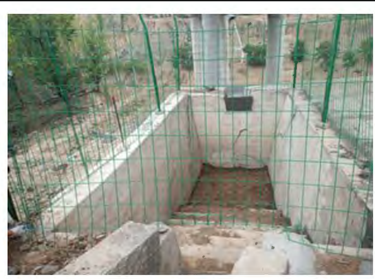
格曲大桥上部设置防撞护栏，安装桥面径流收集管道，桥梁下方修建防渗应急池
