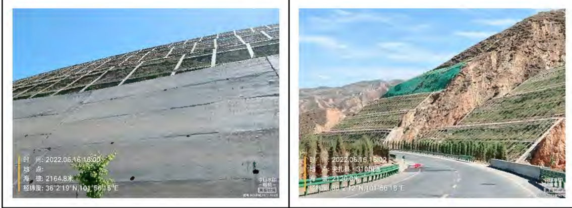
路堑墙及锚杆框架梁防护
