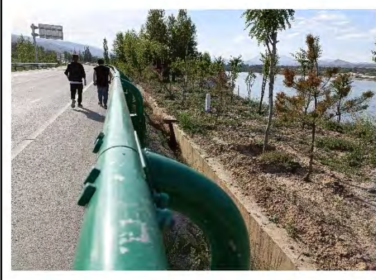
K1+230-K4+100 饮用水源保护区临河面加装高等级防撞护栏，在排水渠下设置应急池
