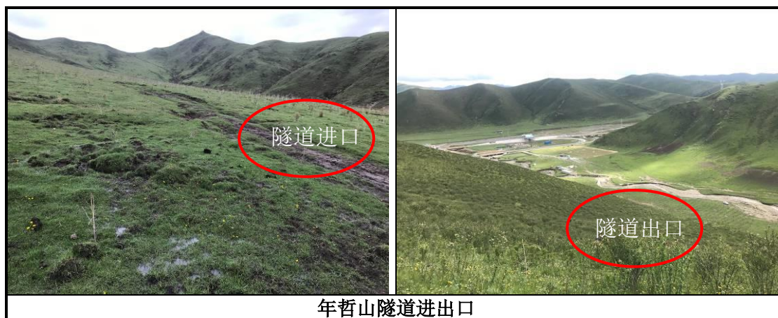
图 4.1-1 隧道进出口现状照片
