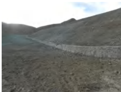
弃渣场挡渣墙
