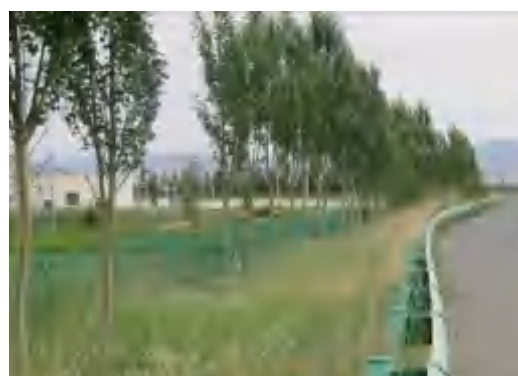
路基工程区边坡植被恢复
