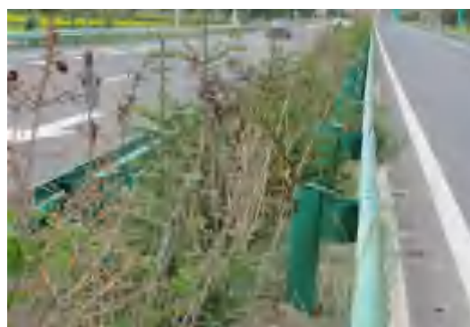
路基中央分隔带植被恢复
