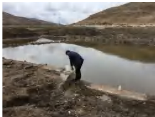
k88+550 甘德县饮用水源取水口
