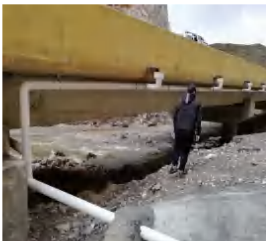
俄合玛纵向大桥的桥面径流收集系统
