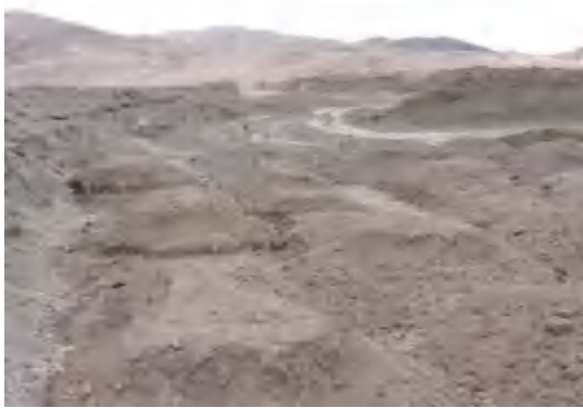
施工 3 标施工废弃物清运至弃渣场
