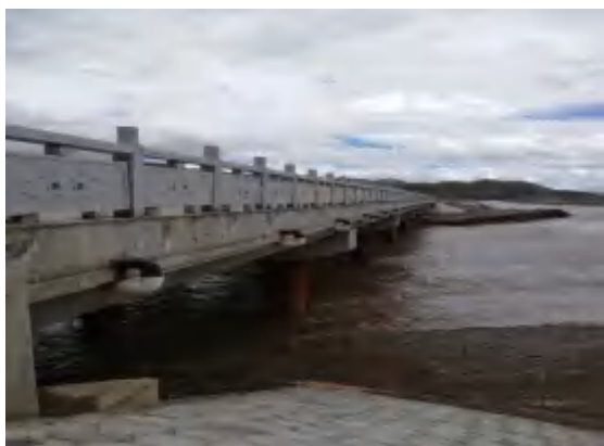
甘德大桥的桥面径流收集系统
