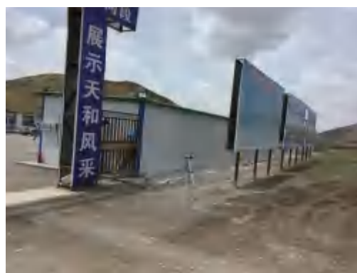
k43+040 施工 2 标沥青拌合站
