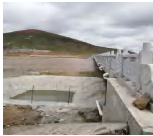
达日黄河大桥的桥面径流收集系统
