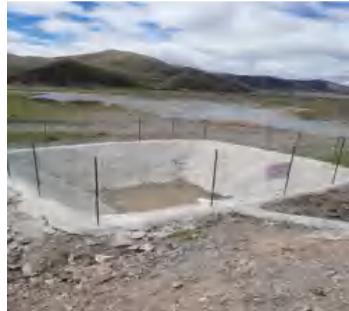
当曲河中桥的桥面径流收集系统
