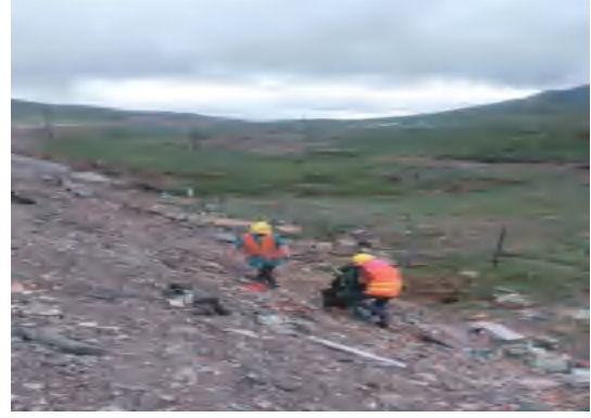
清除施工现场垃圾
