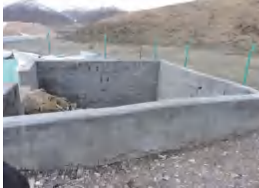
施工 2 标设置的生活垃圾收集池
