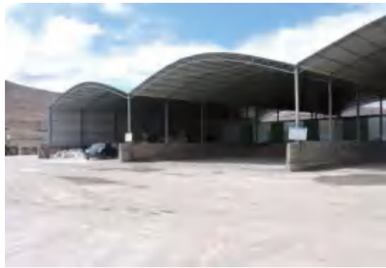
施工5标拌合站储料仓设置的抑尘设施
