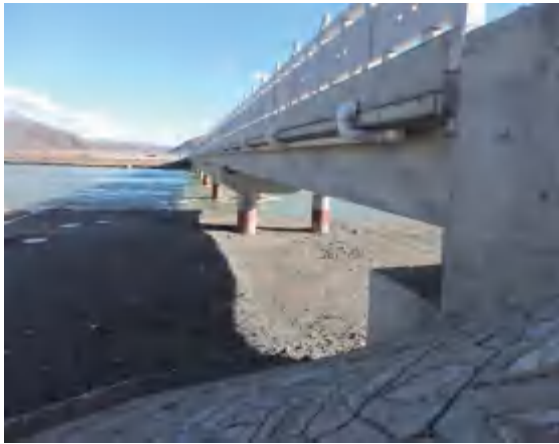
达日黄河大桥的桥面径流收集系统
