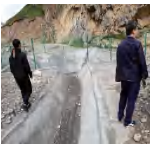
俄合玛纵向大桥的桥面径流收集系统
