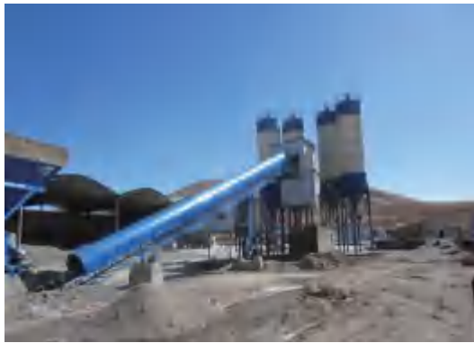
施工3标拌合站及料仓的抑尘设施
