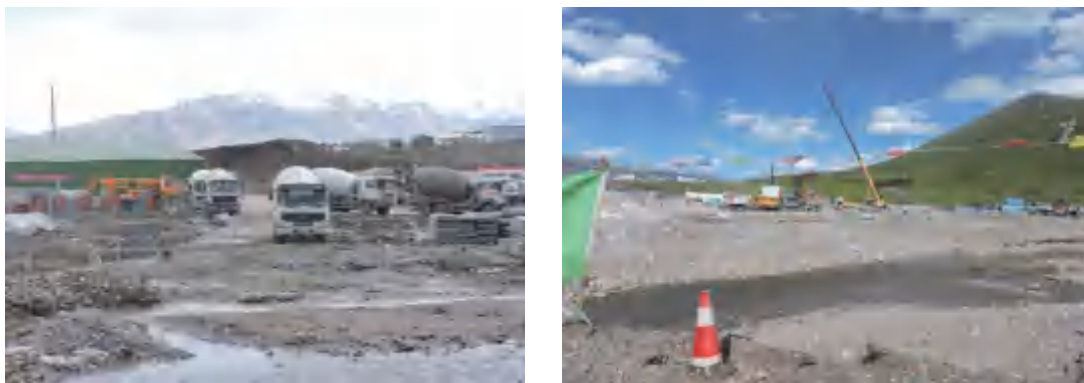
施工 1 标拌合站场地整改前后对比
