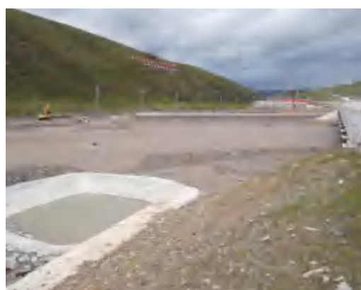
甘德大桥的桥面径流收集系统
