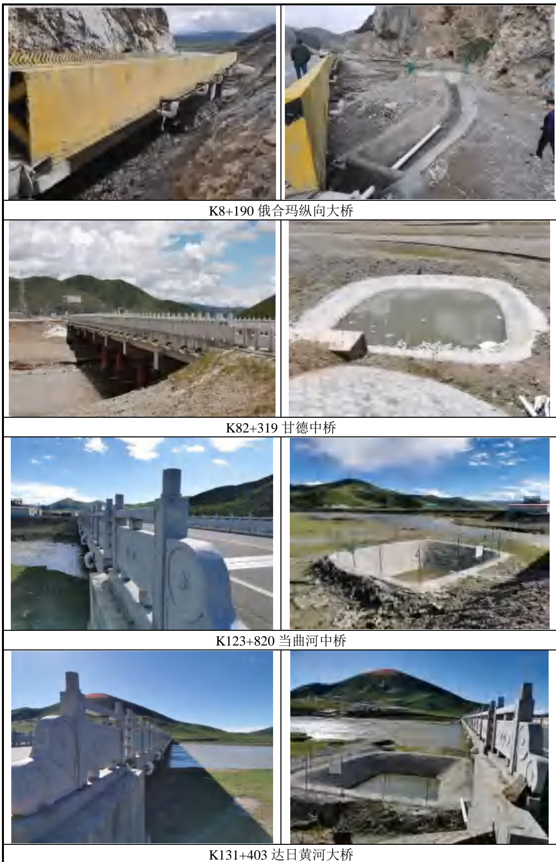
图 7.3-1 本工程桥梁桥面径流收集系统现状照片
