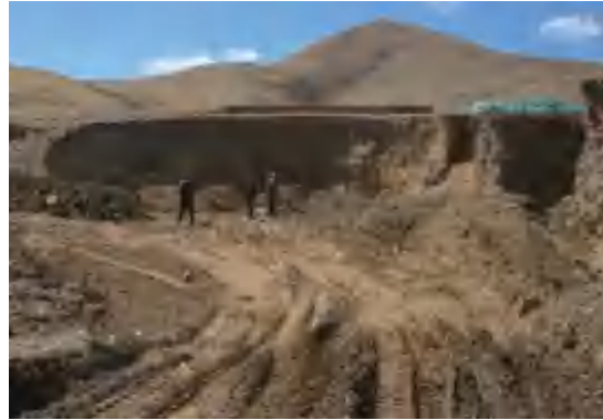
施工 4 标施工废弃物清运至弃渣场并平整
