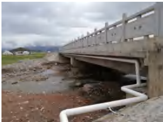
K8+103.835中桥的桥面径流收集系统
