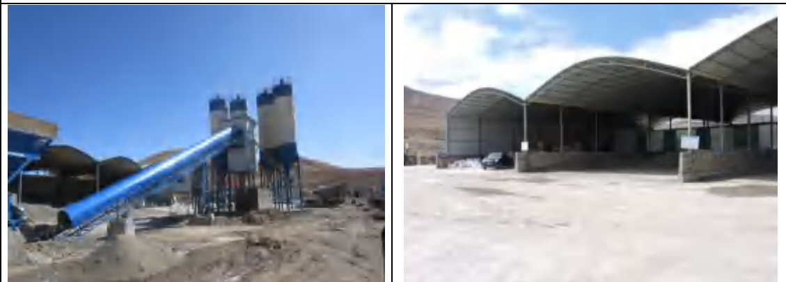
拌合站抑尘设施
